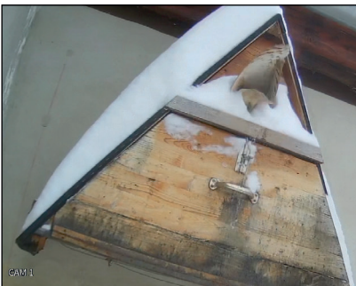
Abbildung 4: ... bohrt sich durch die Schneewand ...
